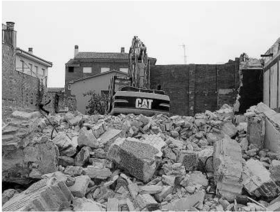
La Societat ja fa unes setmanes que s'ha enderrocada. Tot és a punt per construir el nou centre cultural. / A.P.
